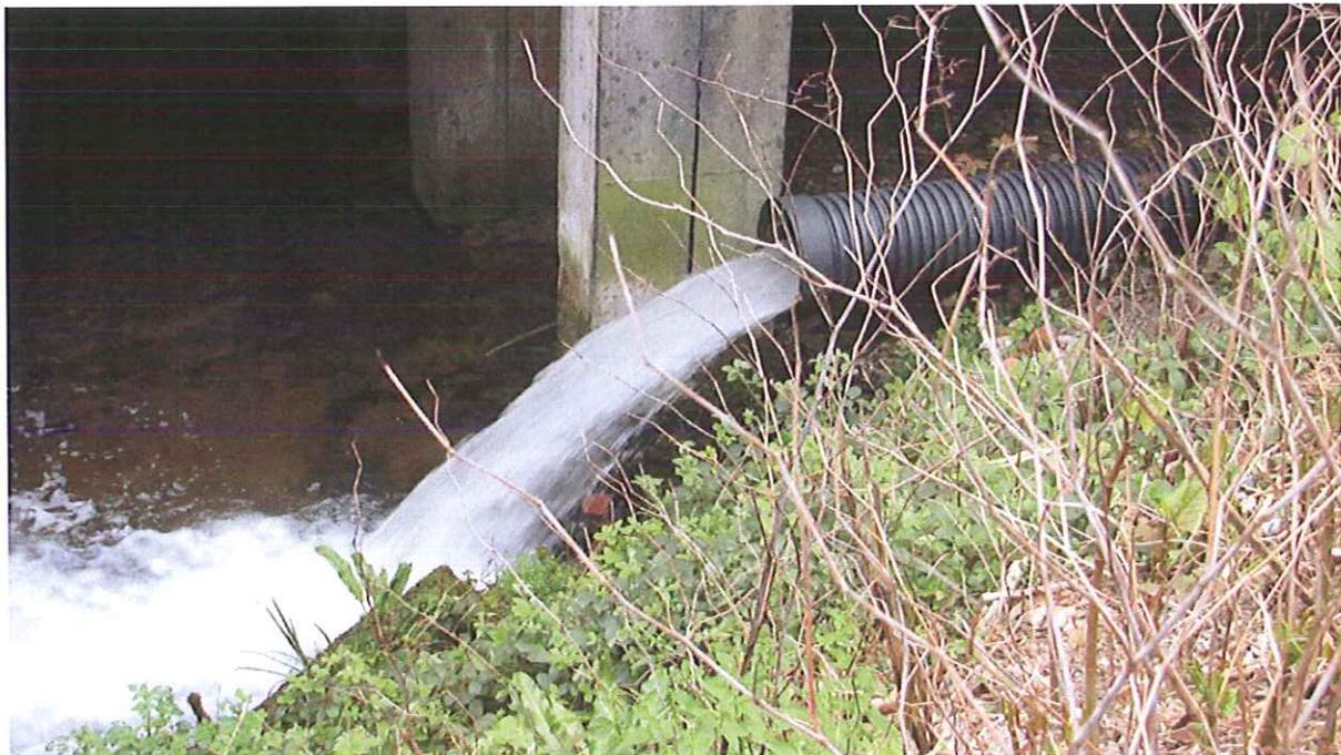
Le bassin de dissipation permet la lecture de la lame d'eau et donc le contrôle du débit réservé.
